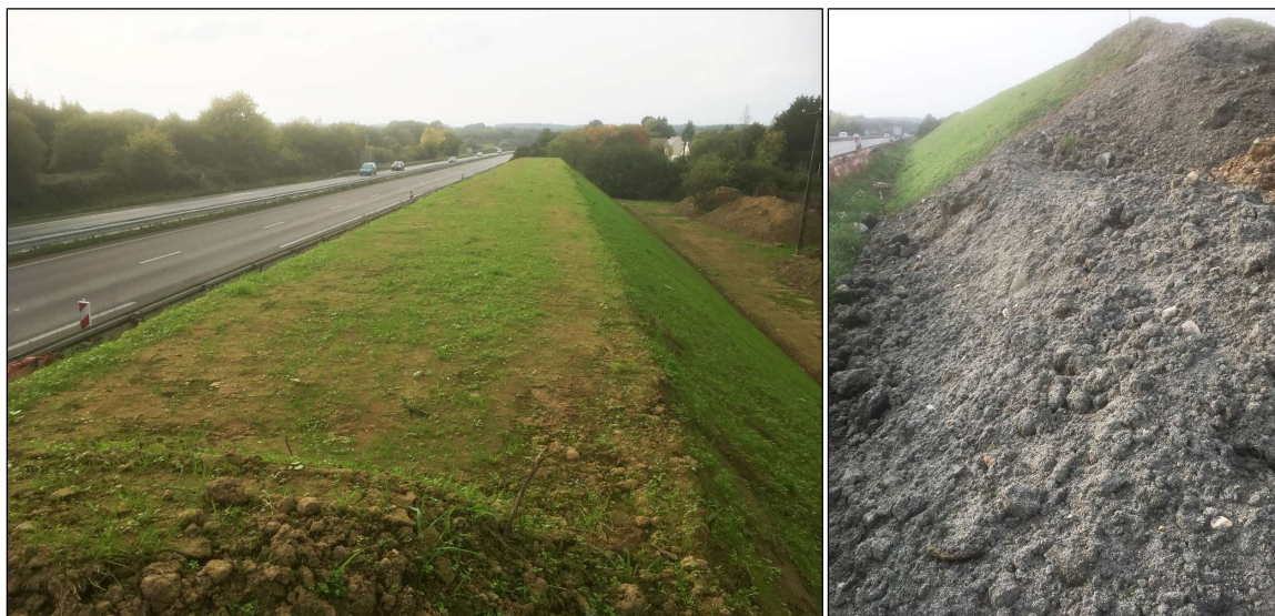
Figure 11 : Exemple de merlon paysager composé de sédiments (Commune de La Trinité-Surzur / IDRA)
