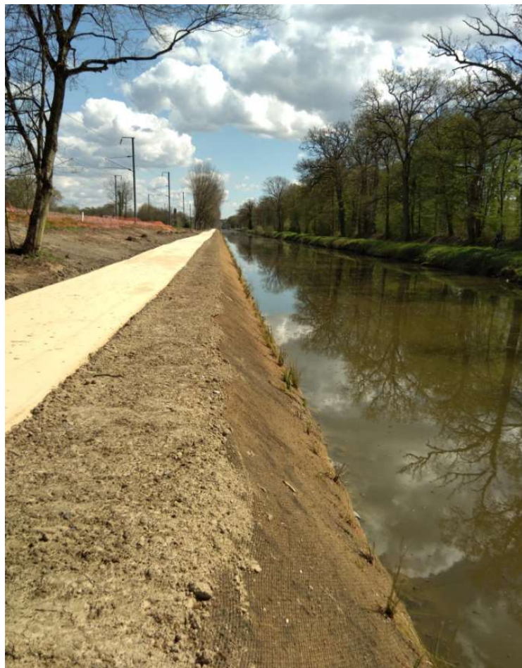
Figure 15 : Illustration d'une réfection de berge avec des sédiments (Canal d'Ille et Rance, bief, de Fresnay, 2022)
