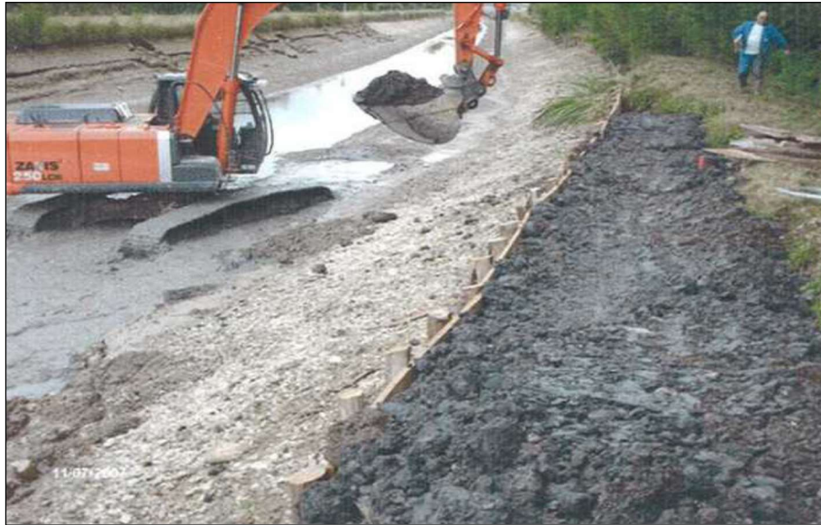
Figure 10 : Mise en œuvre de confortement sur berges (CETMEF - 2010)
