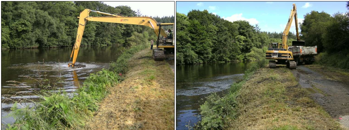
Figure 3 : Exemple de dragage mécanique à partir d'une berge
