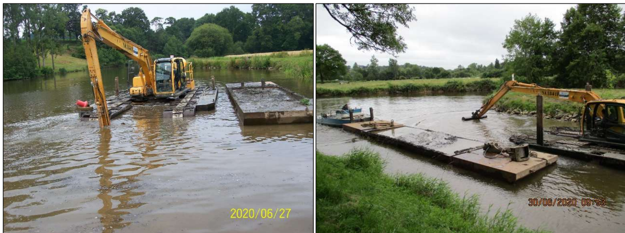
Figure 2 : Exemple d'atelier Dipper (ponton-pelle) et de pelle amphibie avec chargement de barge (photo IDRA Environnement et Région Bretagne)
