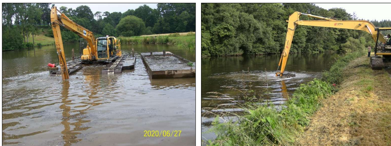
Figure 17 : Exemple d'ateliers de dragages mécaniques
